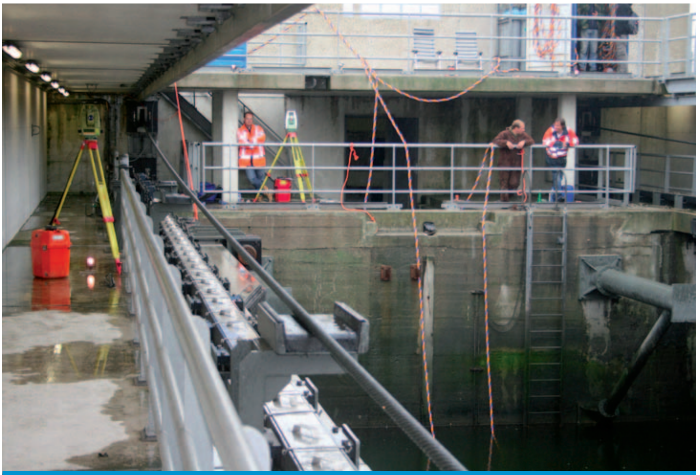
Voor Rijkswaterstaat in de Noordersluis van IJmuiden (foto Geovisie).
