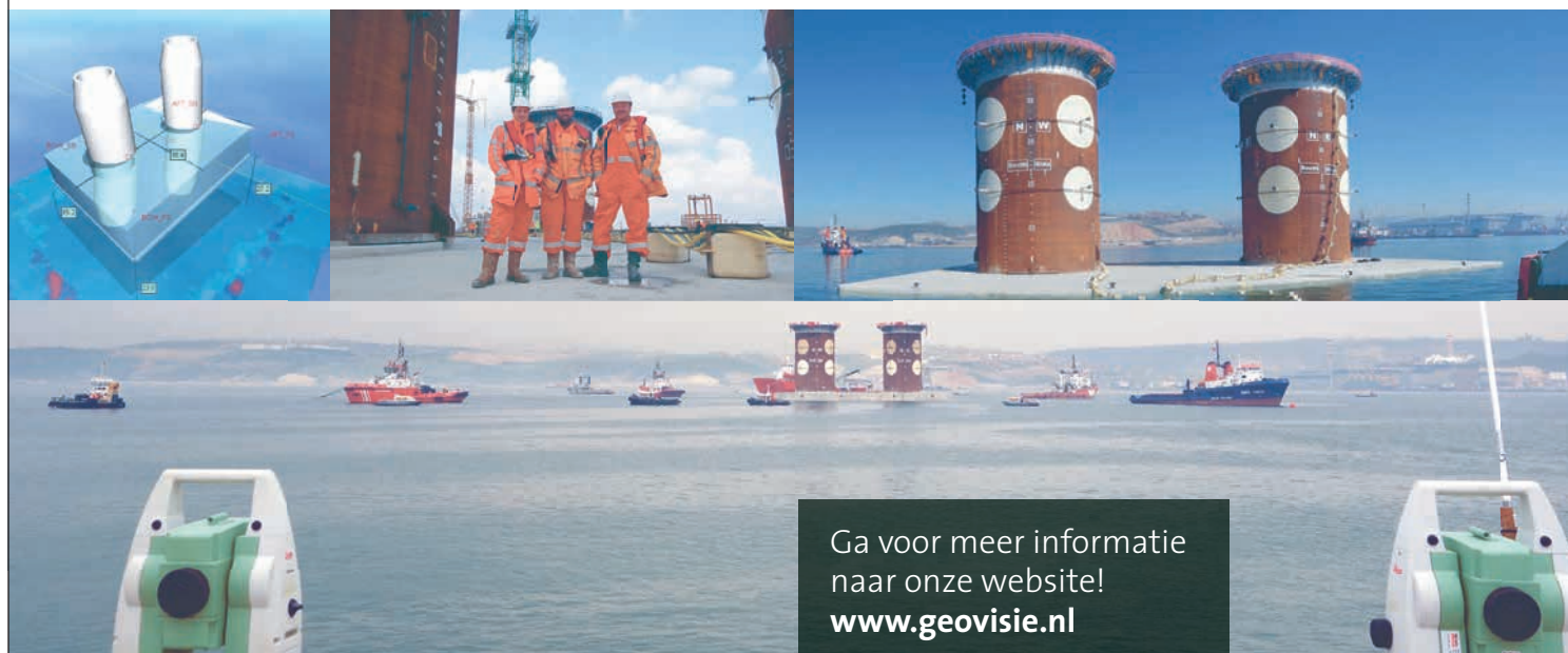
Foto's: Positioneren van twee cassions (67x54x42m) voor de Izmit Bay Bridge
